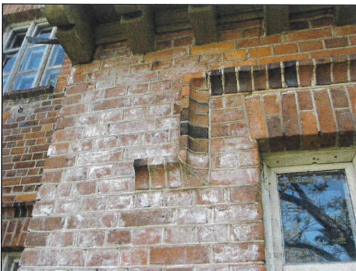
VIRŠ LANGŲ PLEIŠTINIŲ SĄRAMŲ ESANTYS SANDRIKAI IŠ RAUDONŲ PLYTŲ
