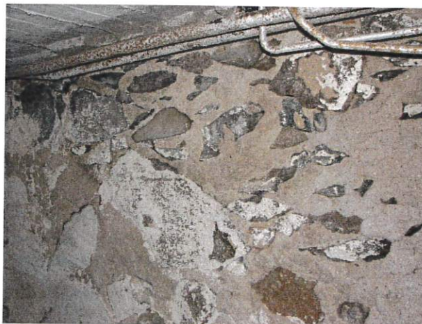
RŪSIO SIENOS IŠ LAUKO AKMENŲ MŪRO (IŠORINĖ SIENA KIEME)
